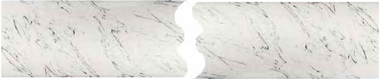
Bild 5. Serpentina-Deckfugen, Spiegelschnitt vor Verklebung
